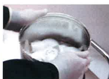
シーリング材缶を上から押す 水平の確認
